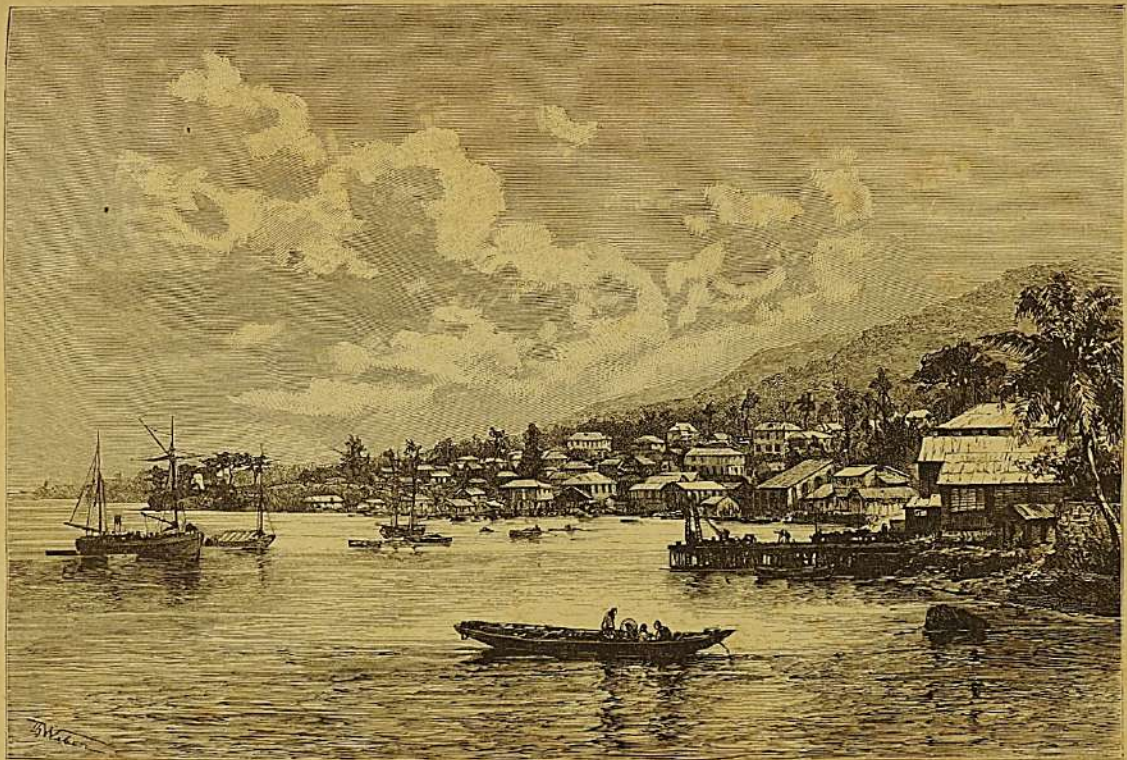
BAIE DE SAWPIT, PRÈS DE FREETOWN Dessin de Th. Weber, d'après une photographie de M. Bonnevide.
