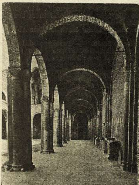
S. Ambrogio. Lato destro del Portico (fot. Alinari).
