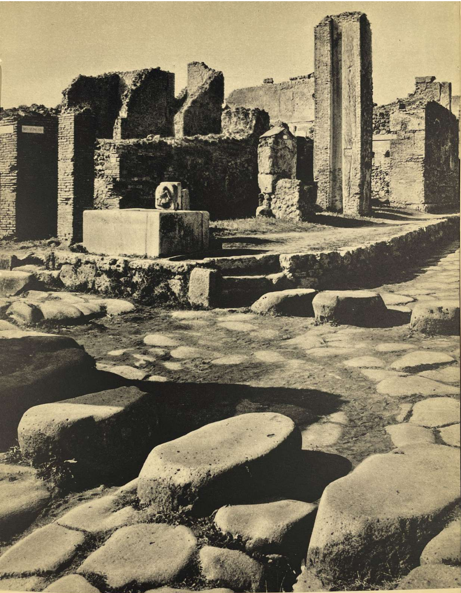
13. — Quadrivio della Via di Stabia con la Via di Nola
