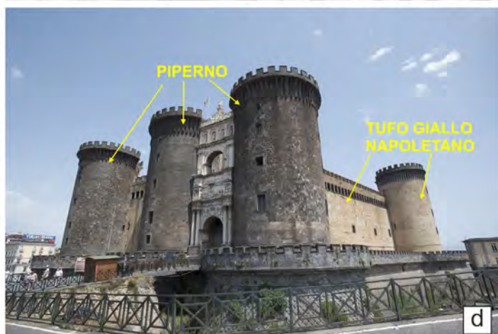
Figura 20. - (a) Tufo Giallo Napoletano; (b) microfotografia al microscopio elettronico di cristalli di phillipsite (zeolite); (c) Piperno con le classiche "fiamme" di scorie appiattite; (d) il castello del Maschio Angioino di Napoli.
